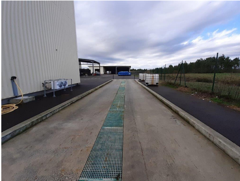
Figure 11 : Aire de remplissage et de dépotage de l'usine Thalie
